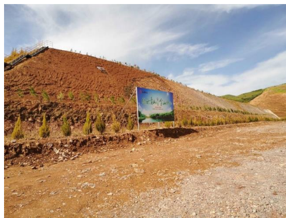
照片 2-4 终了边坡治理
