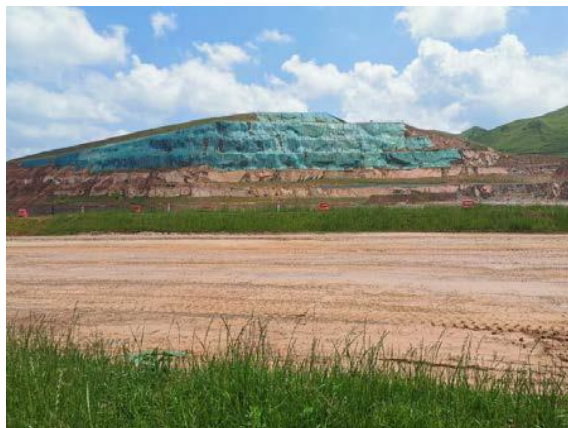
照片 2-5 采场边坡挂网喷播效果
